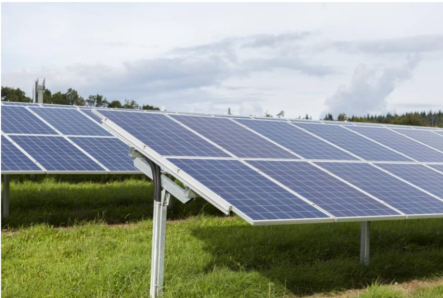
Kuva 37. Esimerkkikuva aurinkopaneeleista (Sweco Finland Oy).
