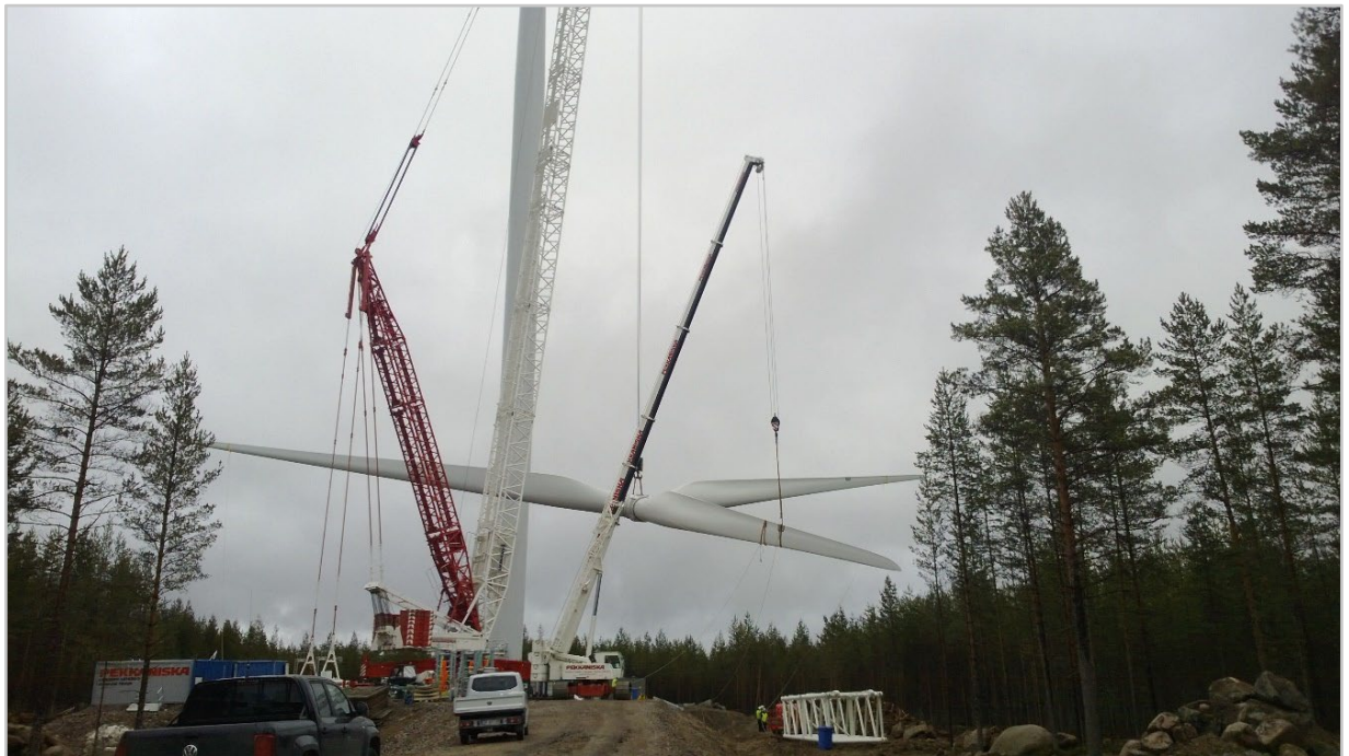
Kuva 45. Esimerkkikuva voimalan lapojen nostamisesta nosturilla. (Taaleri Energia Oy)
