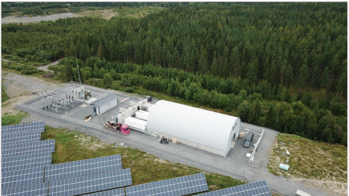
Kuva 41. Havainnollistava kuva katetusta sähköasemasta ja akkuvarastosta. Kuvan akkuvaraston teho ja kapasiteetti ovat pienemmät (30MW/36MWh) kuin Kivinevalle on suunniteltu. Akkuvaraston kattamisen tarve selviää tarkemman suunnittelun yhteydessä. (Taaleri Energia Oy)
