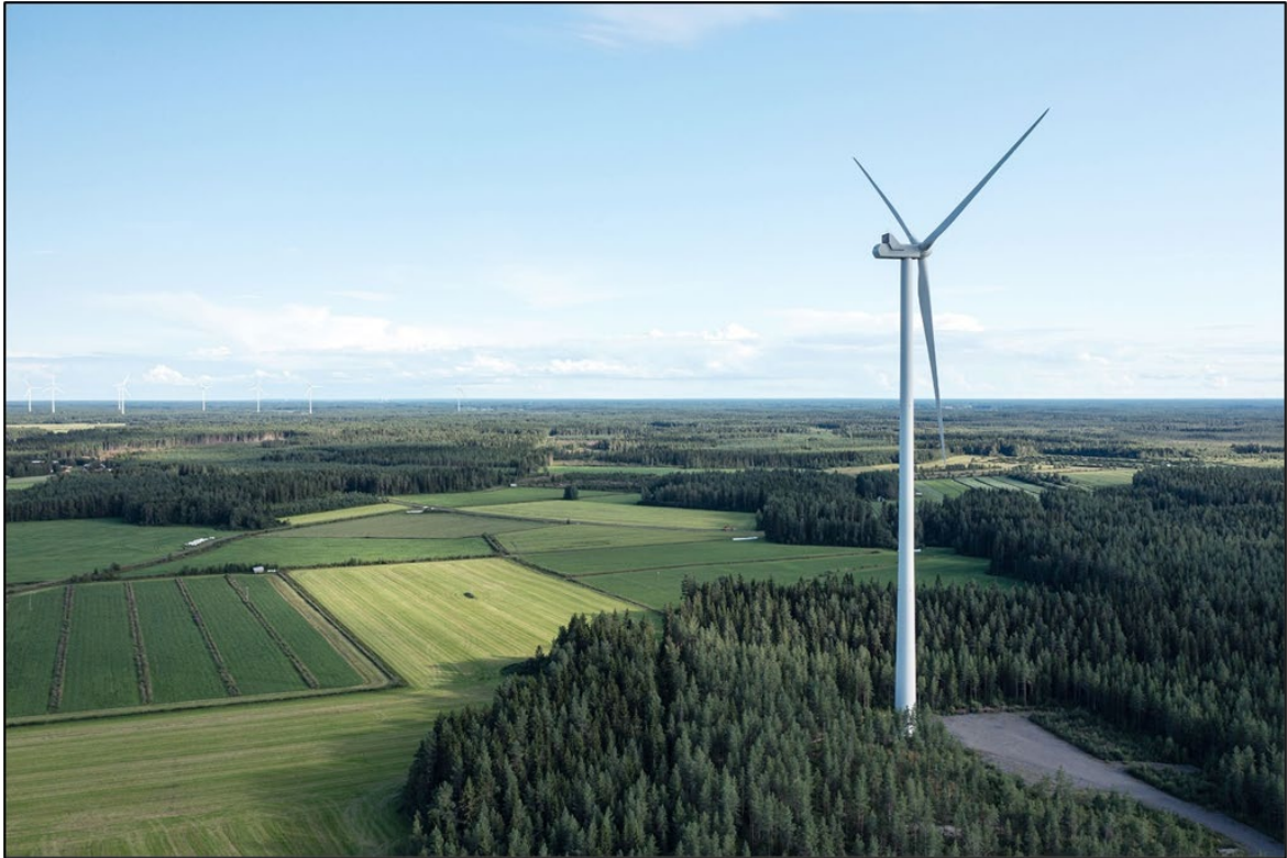
Kuva 32. Valmis voimalaympäristö (Kuva: Taaleri Energia Oy)
