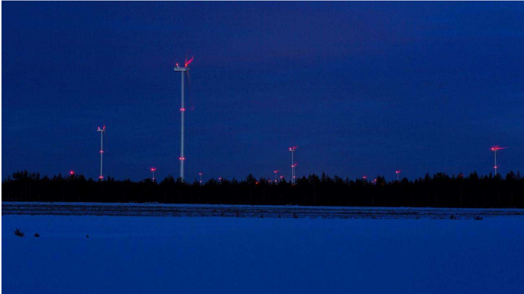
Kuva 80. Kiinteät punaiset lentoestevalot pimeällä. (Kuva: FCG)
