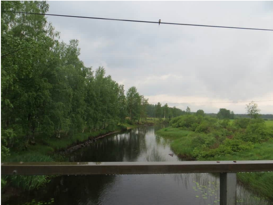
Kuva 3. Lamujoki Peltoperäntien sillalta kuvattuna.
