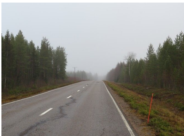
Kuva 8. VE 3 ylittää Pihkalantien, kuva etelään.
