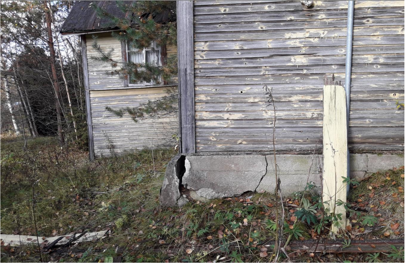
Kuva 12. Kukkolan päärakennuksen betonoitua kivijalkaa ja lautaverhoilua.
