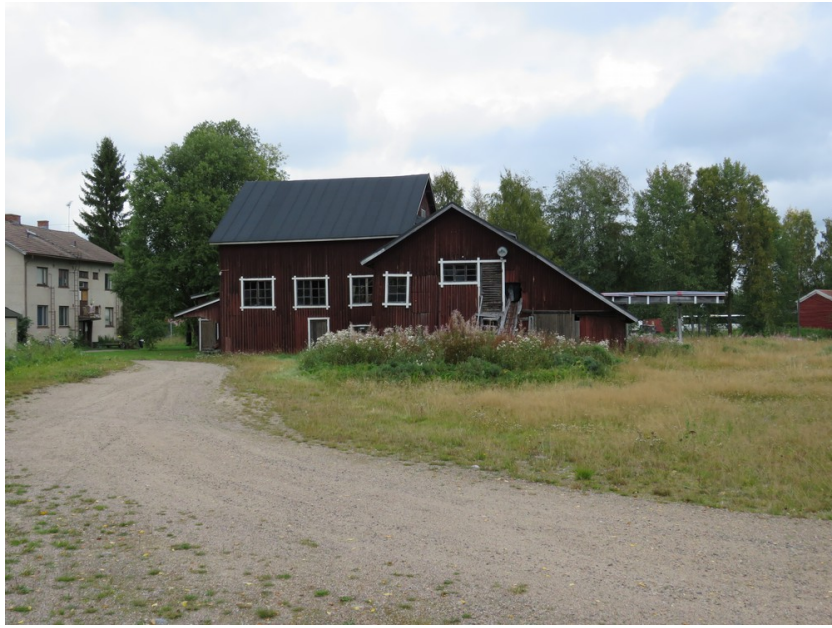
Pellin talo on sijainnut Lamujoen vanhan saharakennuksen itä- ja kaakkoispuolella, kuva pohjoiseen.
