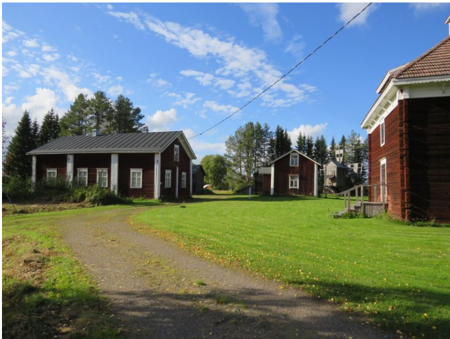
Museon pihalue ja rakennuksia luoteeseen, vasemmalla entinen kappalaisen puustelli.
