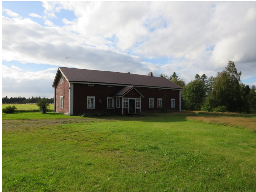
Tuomaalan vanha päärakennus kuvattuna luoteeseen.
