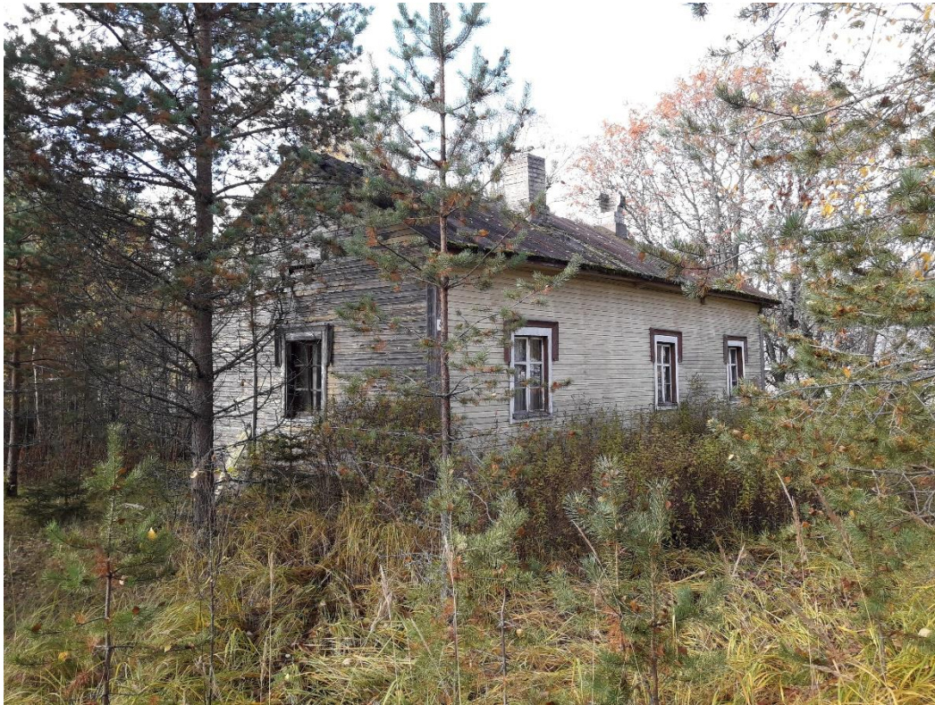
Kuva 1. Kukkolan päärakennus Torpantieltä kuvattuna
