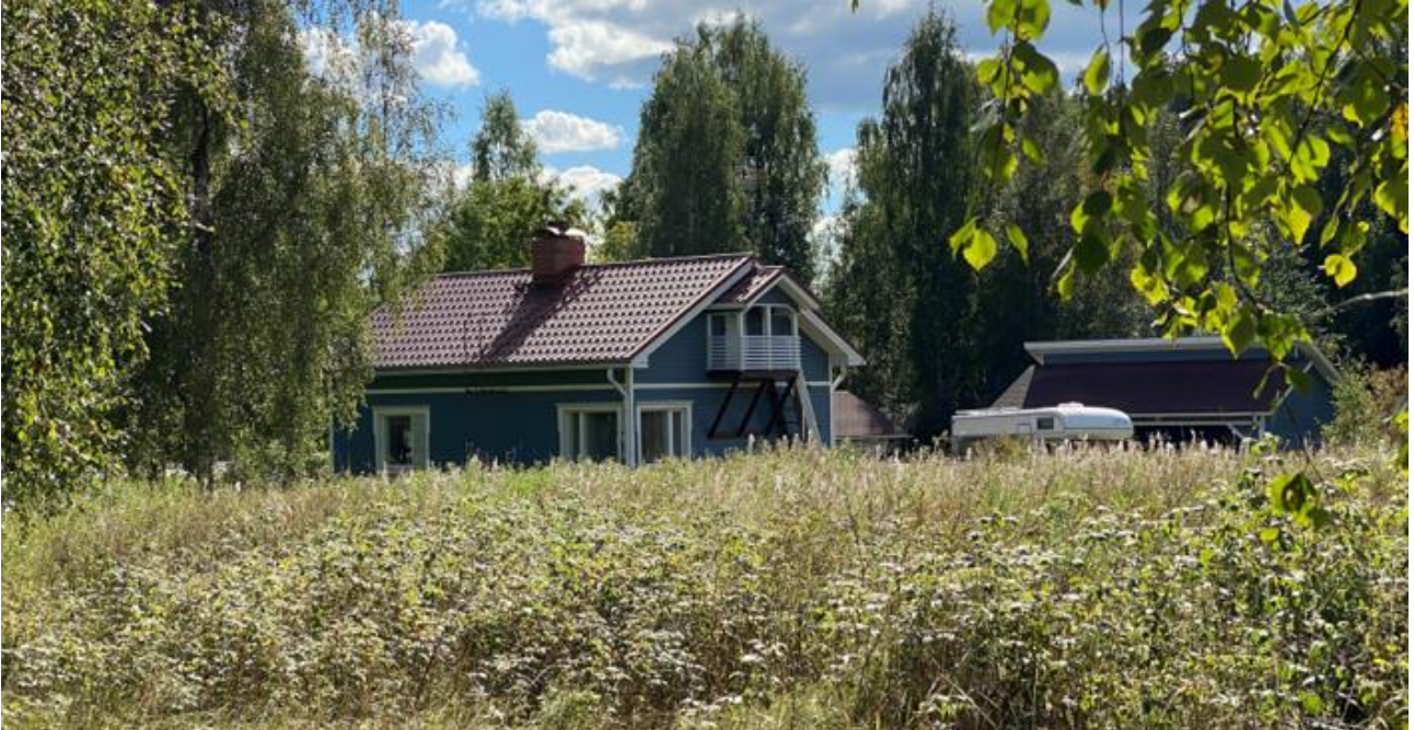
Torpantie päässä sijaitseva Savelan asuinrakennus.
