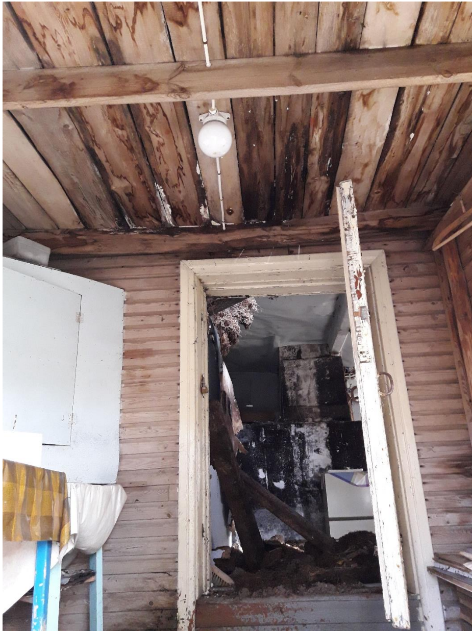
Kuva 3. Rakennuksen ulko-ovi ei ollut lukittu. Kuistin sisäkatossa näkyy vesivuotojen jälkiä ja sisempänä katto on romahtanut. Rakennus ei ole turvallinen.
